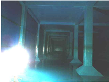
<배수지 1지 전경>
