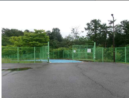
<배수지 입구부 상태양호>
