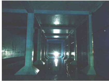
<배수지 2지 전경>
