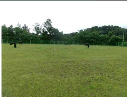
<배수지 상부 상태양호>
