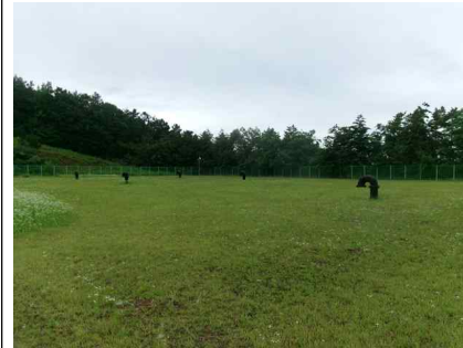
<배수지 상부 전경>
